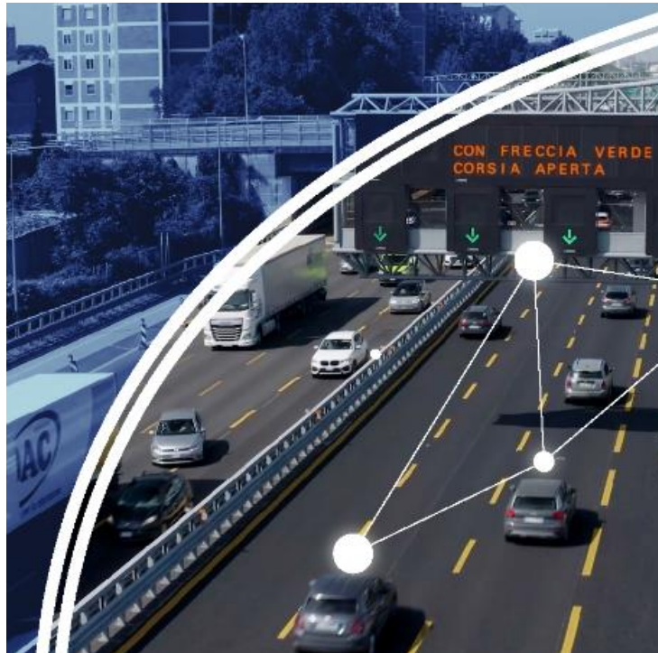
Dynamic Traffic Flow System on the A4 Torino-Trieste of Autostrade per l'Italia SpA
