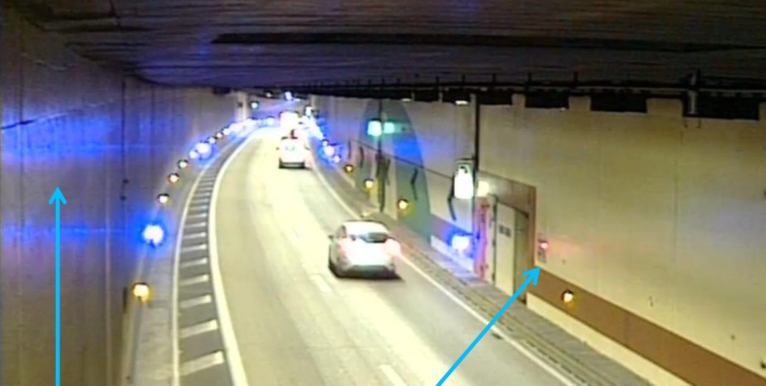
Inaccurate « Wrong way » alarm
